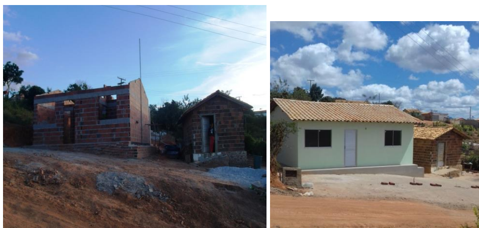
Figuras 14 e 15 – Casas do PNHR durante o processo de construção
