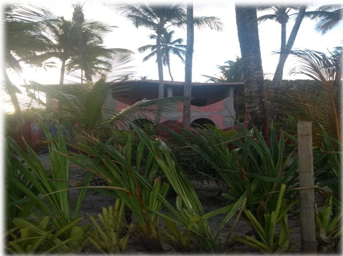
Residência à beira mar na costa do Pé de Serra, arquivo pessoal.
