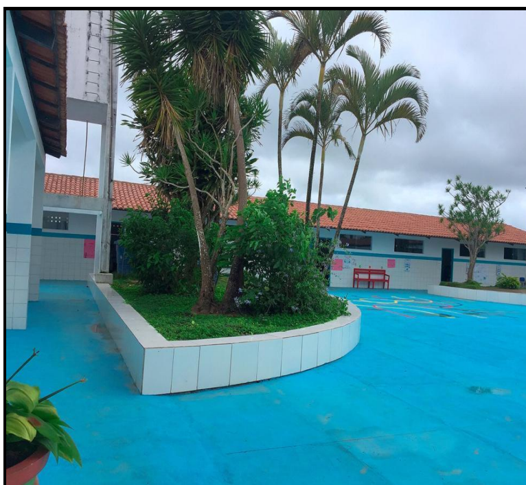
FOTOGRAFIA 4 - Pátio da EPMCMJ, Maracás, BA, 2021 após reforma
