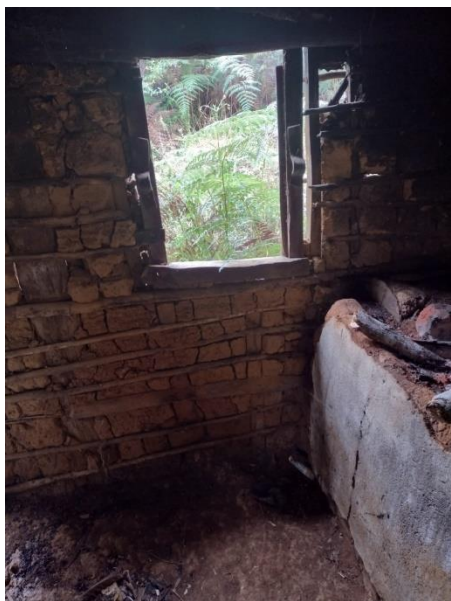
Cozinha de uma casa construída com barro e madeira
