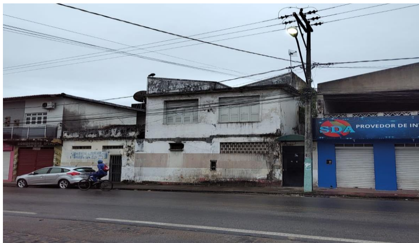
Figura 12 - Antigo prédio da EPMAV na Praça dos Cometas, Ipiaú-BA
