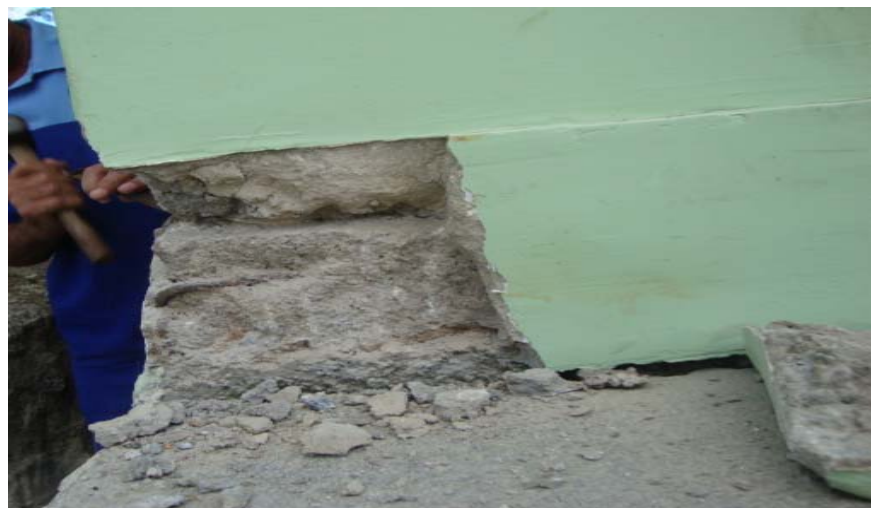
Figura 07 – Baldrame e pilar / armadura amostra
