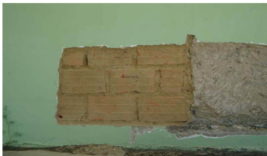
Figura 02 – Detalhe de alvenaria
