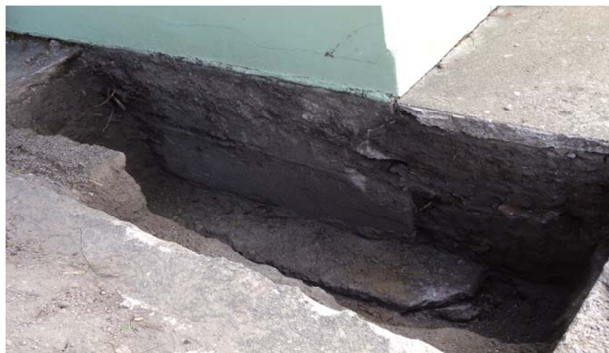
Figura 08 – Vista da sapata corrida
