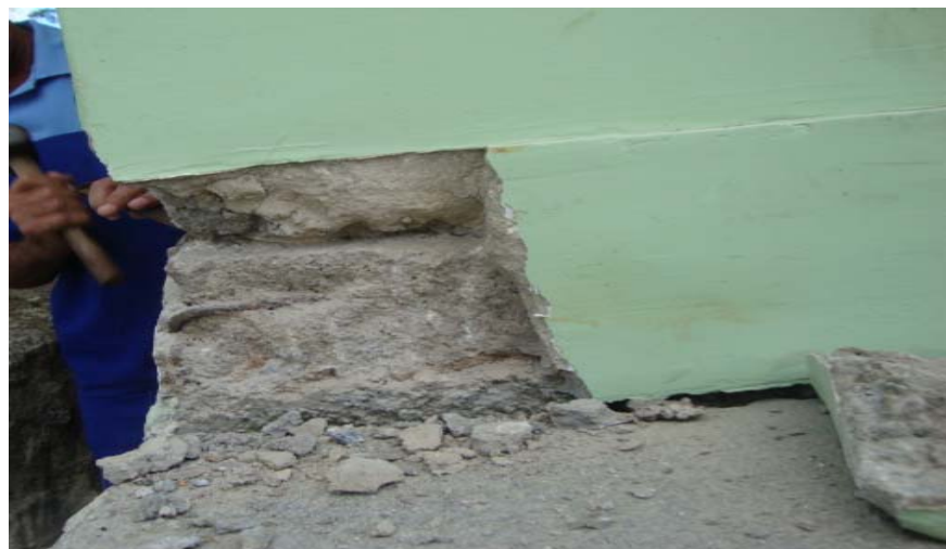
Figura 07 – Baldrame e pilar / armadura amostra
