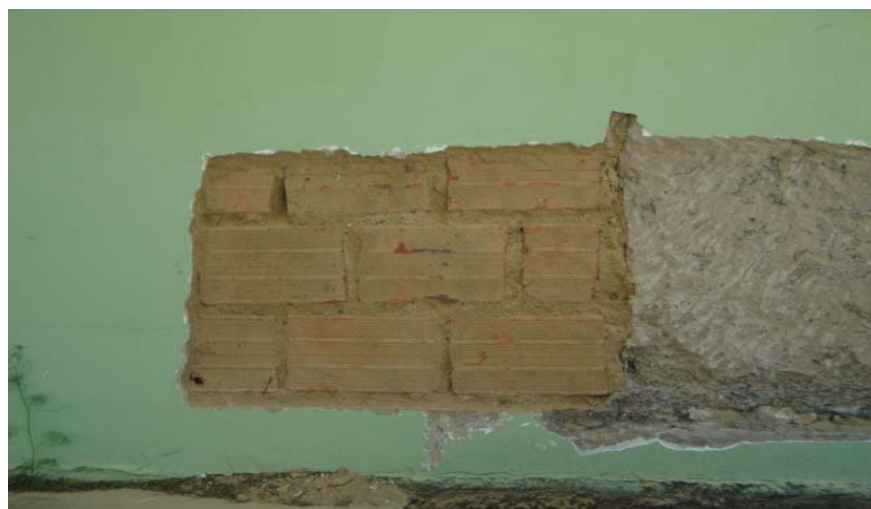
Figura 02 – Detalhe de alvenaria
