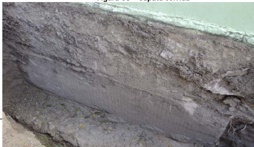
Figura 03 – Sapata corrida
