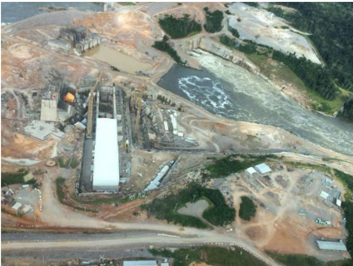
Figura 5- Vista aérea UHE Teles Pires. Fotografia: Fabiano Rocha.
