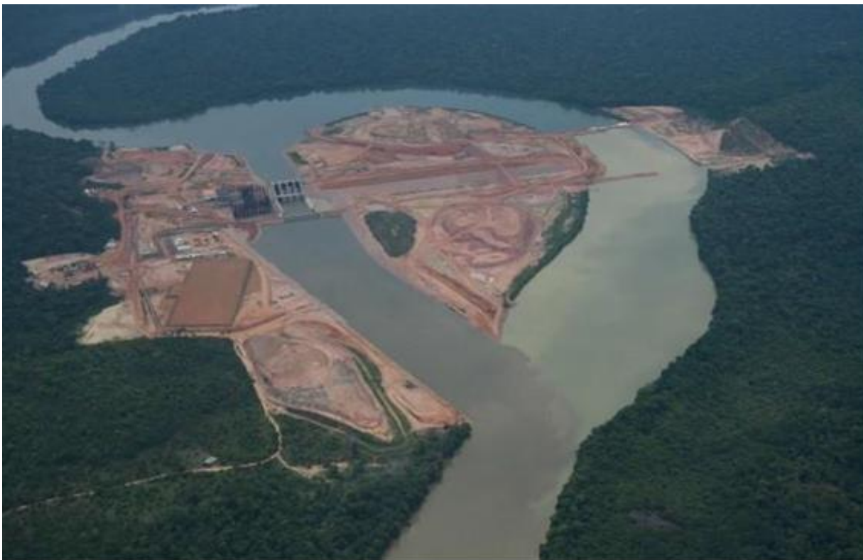
Figura 3- Vista aérea UHE Teles Pires. Fotografia: Fabiano Rocha.
