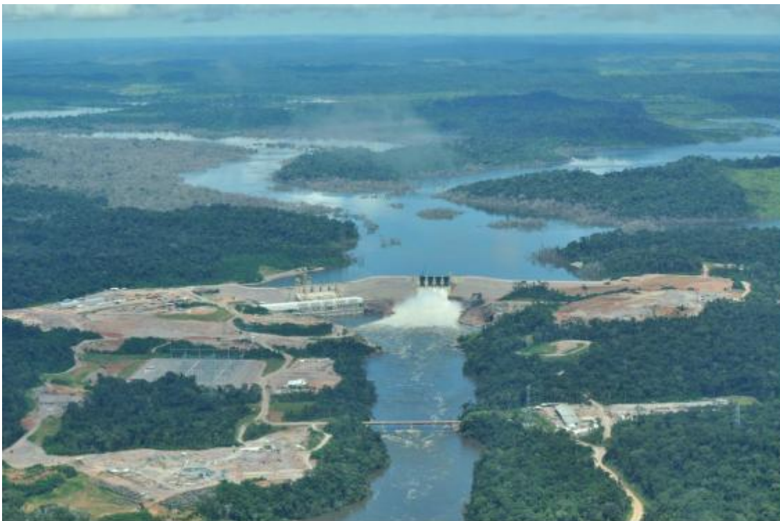
Figura 4- Vista aérea UHE Teles Pires. Fotografia: Fabiano Rocha.
