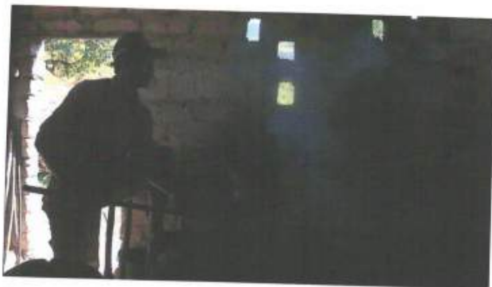
Figura 9 - Entrada de luz vinda por porta e buracos na construção.
