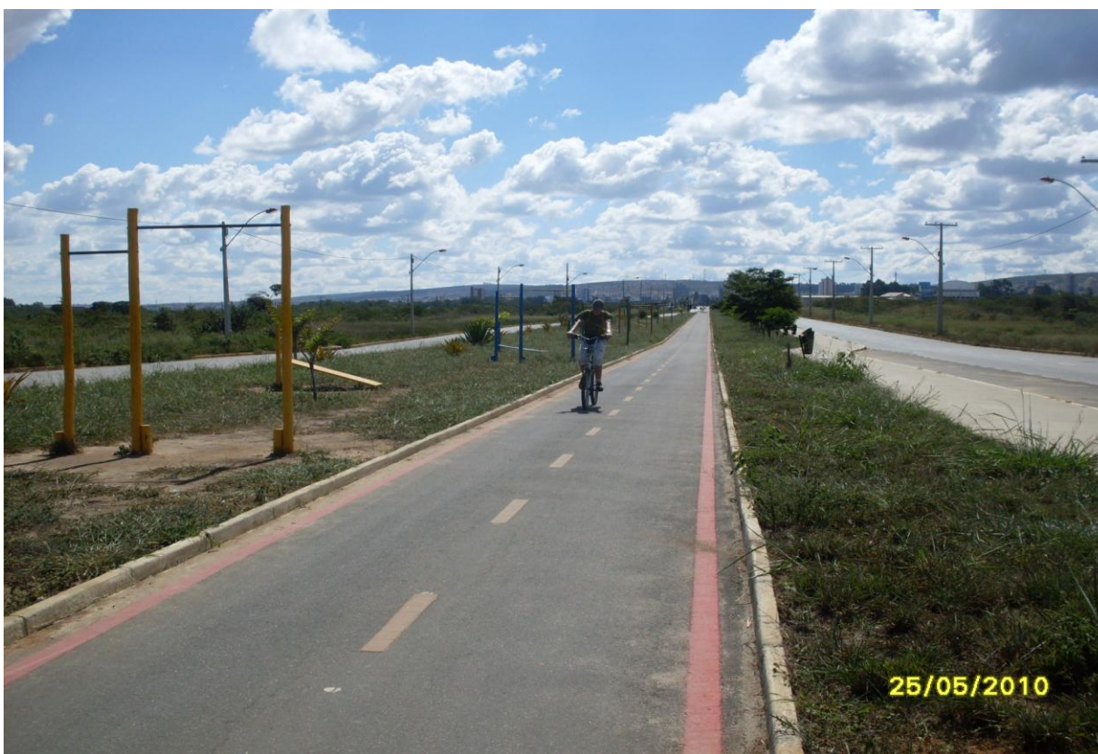
Figura 5 – Duplicação da Avenida Olívia Flores, no sentido Leste em direção a UESB e no sentido Oeste ao Centro comercial da cidade.
