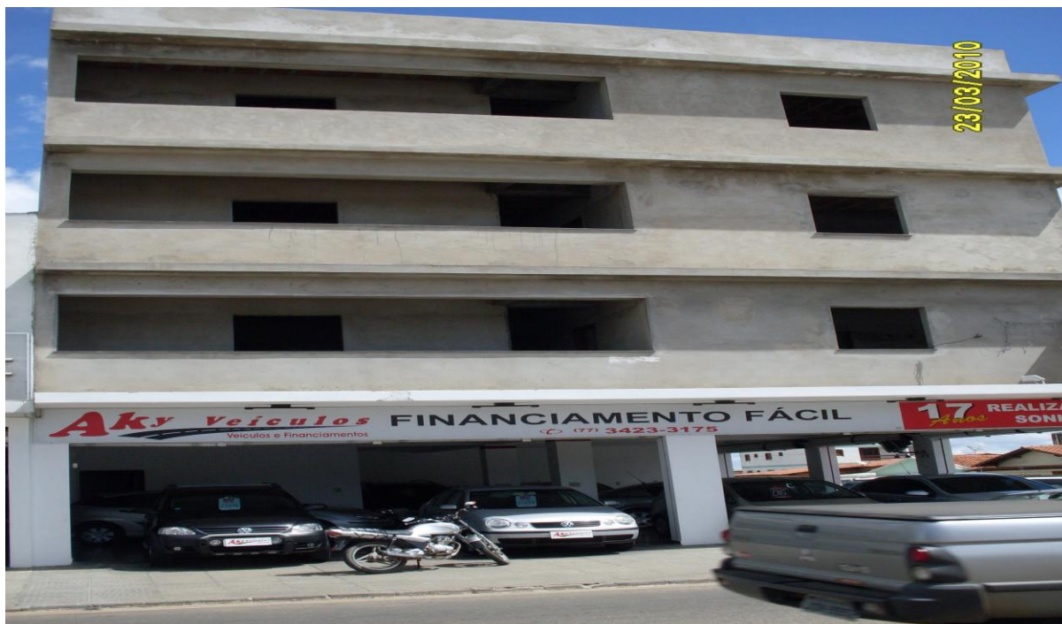
Figura 22 – Prédio em construção e empresa de revenda de automóveis na Avenida Brumado no bairro Brasil.
