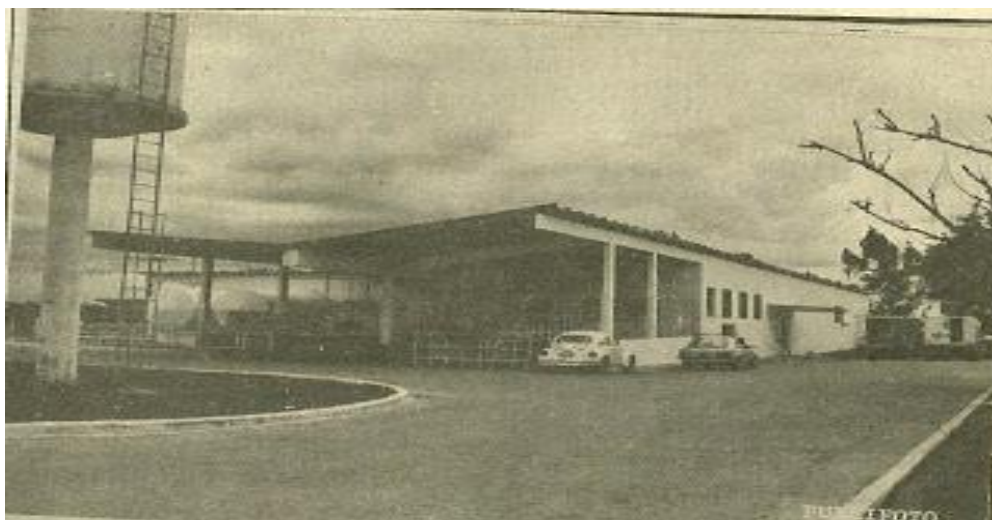
Foto 2 – Instalações da LAVISA - 1978
