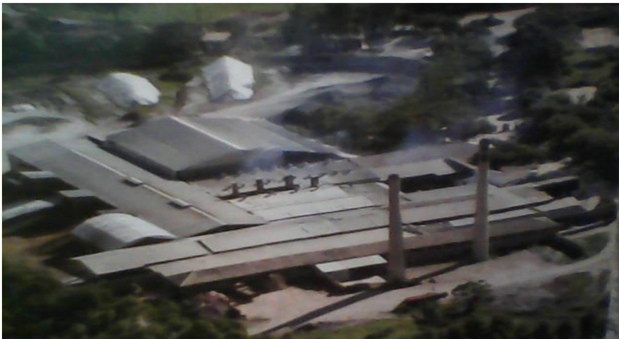
Figura 3 – Vista aérea da indústria Cerâmica Simonassi Bahia Fonte: Folder cedido pela empresa
