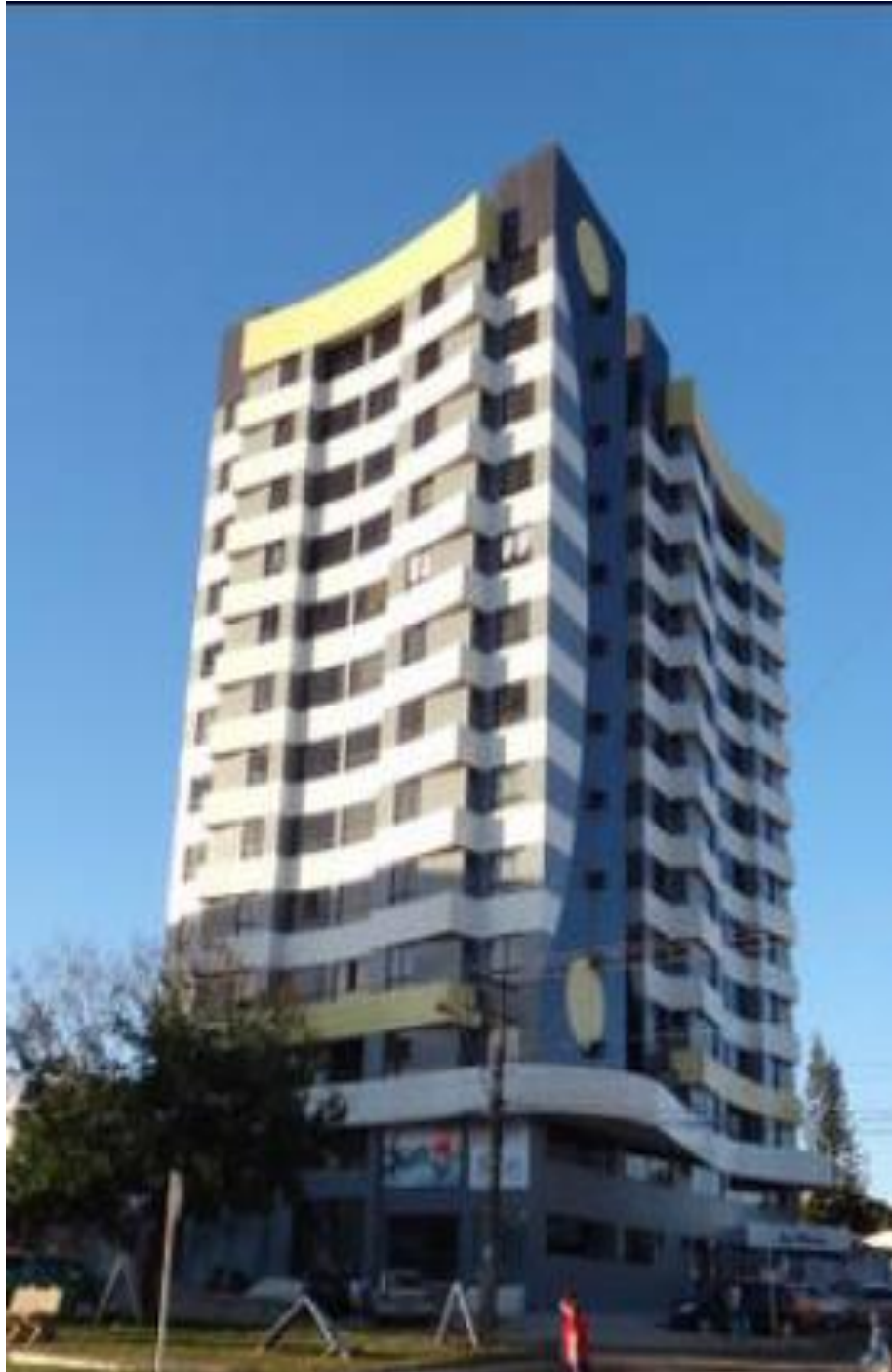
Figura 18 – Edifício com onze andares de apartamentos residenciais sendo quatro unidades por andar.
