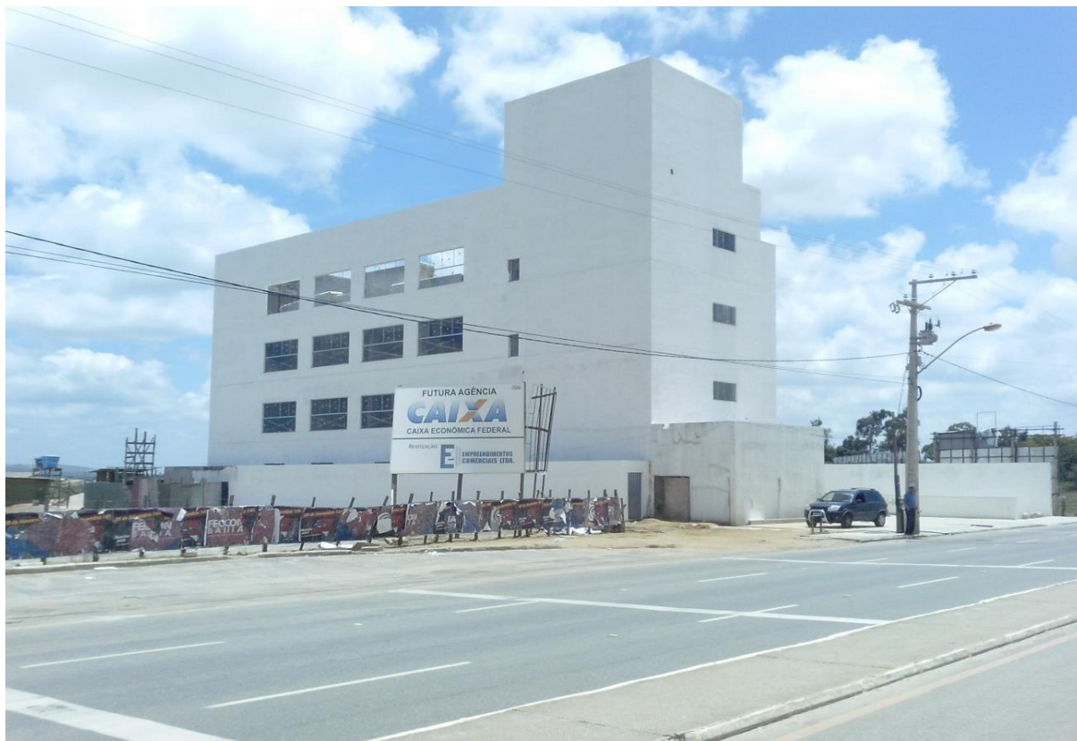
Figura 13: Prédio da futura agencia da CEF.
