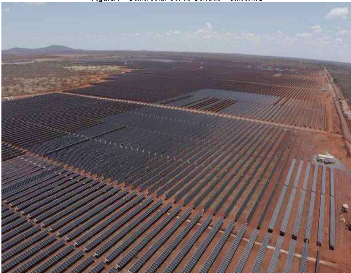
Figura 7 - Usina solar Sol do Cerrado – Jaíba/MG
