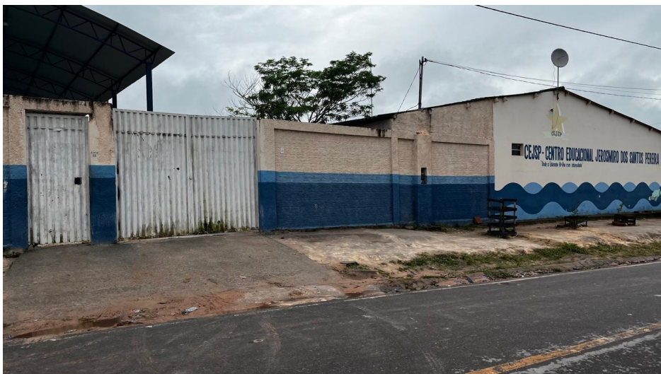
Figura 4: Fachada do Centro Educacional Jerosmiro dos Santos Pereira
