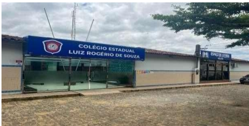
Figura 1 — Fachada do Colégio Estadual Luiz Rogério de Souza
