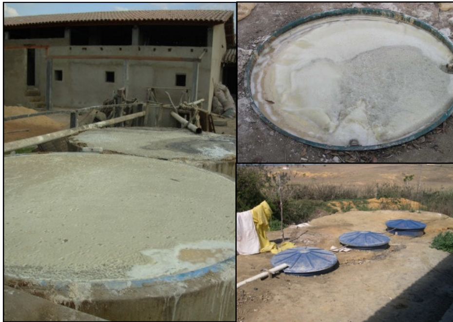
Figura 22. Manipueira lançada em tanques de decantação, Cândido Sales-BA, Belo Campo-BA e Vitória da Conquista-BA, 2007.
