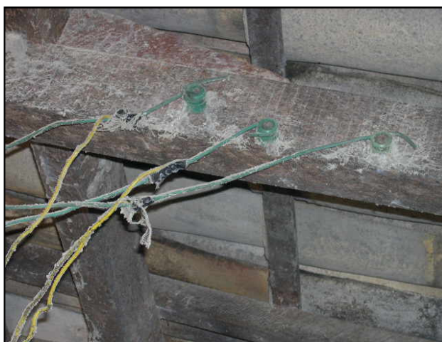
Figura 18. Instalações elétricas inadequadas, Belo Campo - BA, 2007.
