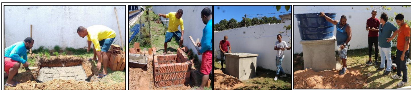
Figura 36. Construção da base para caixa d'água do sistema de captação
