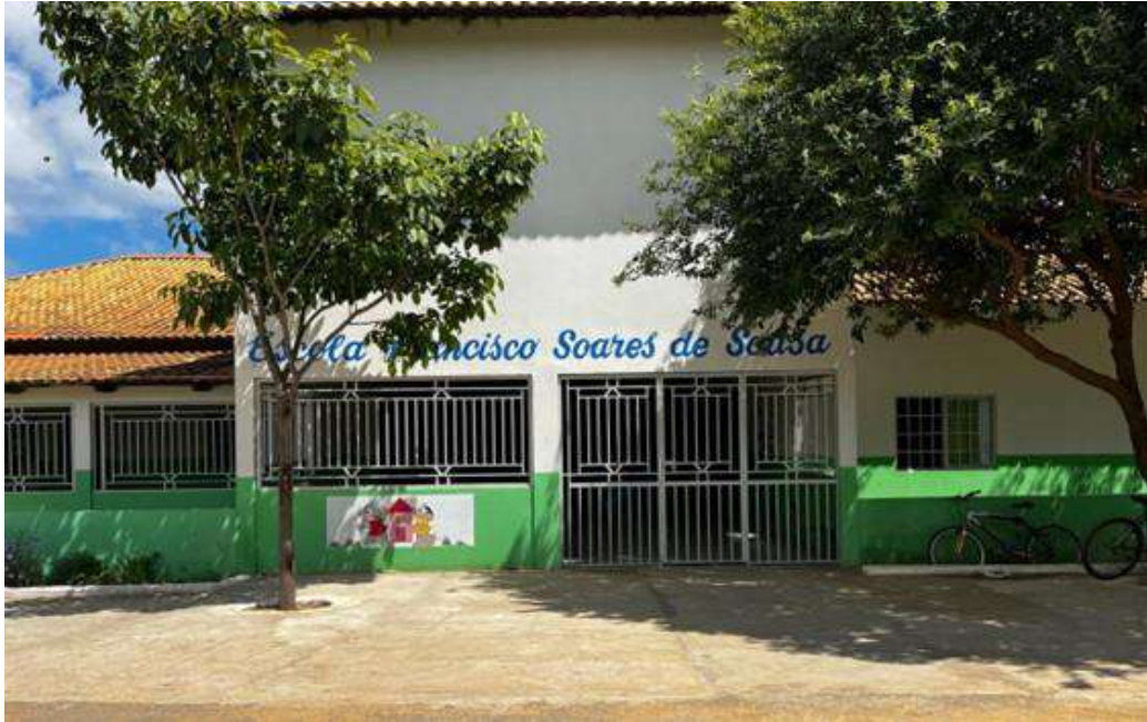
Figura 9 — Fachada da Escola Francisco Soares
