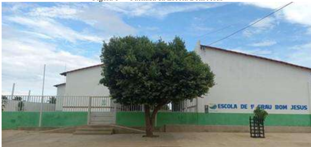
Figura 6 — Fachada da Escola Bom Jesus
