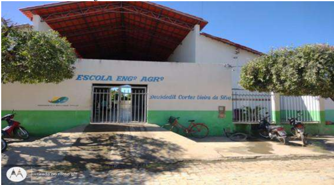
Figura 7 — Fachada da escola Deusdedit Cortez
