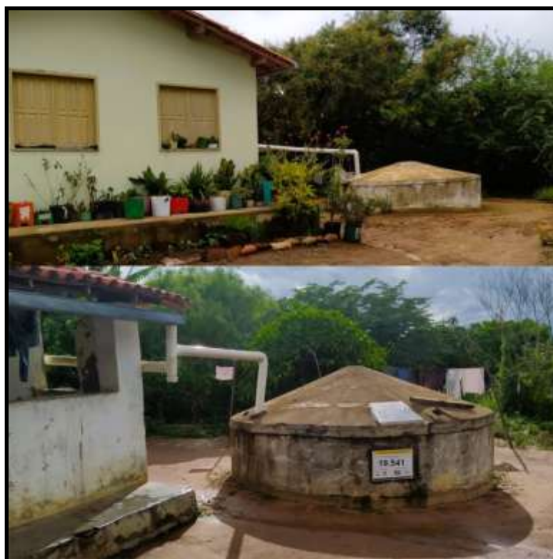
Figura 15- Cisternas de placa, reservatório de água usados para manejo agrícola e consumo, Povoado Mulungu I, Poções-BA
