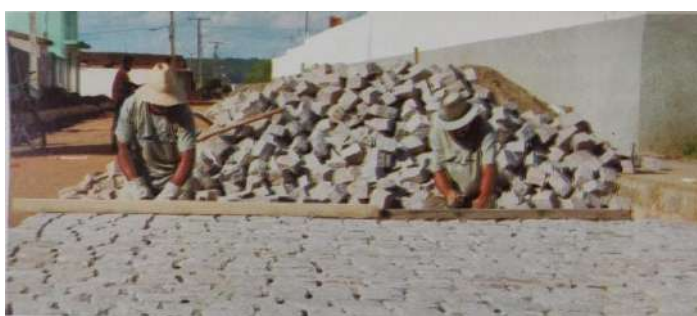
Figura - 20: Pavimentação da rua Eugênio Grilo de Barra do Choça – BA, 2010. Fonte: Arquivo Público, Cinquentenário de Barra do Choça - 2012.
