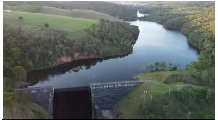
Figura – 37: Imagem aérea da barragem Serra Preta, de Barra do Choça - BA, 2022. Foto: Gutemberg Ferreira de Oliveira, 2022.
