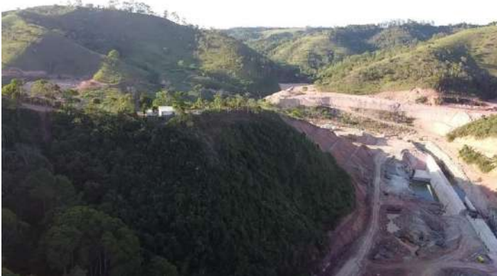
Figura – 38: Imagem aérea da barragem do Catolé em construção de Barra do Choça - BA, 2022. Foto: Gutemberg Ferreira de Oliveira, 2022.
