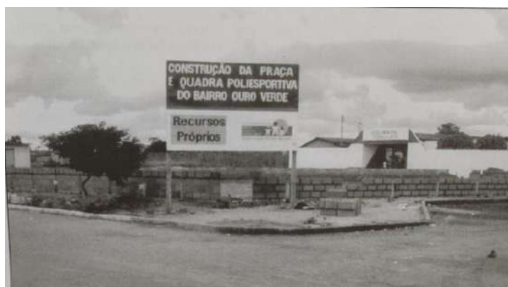
Figura - 23: Construção da Praça e Quadra Poliesportiva do bairro Ouro Verde de Barra do Choça – BA, 2004. Fonte: Arquivo Público, Cinquentenário de Barra do Choça - 2012.
