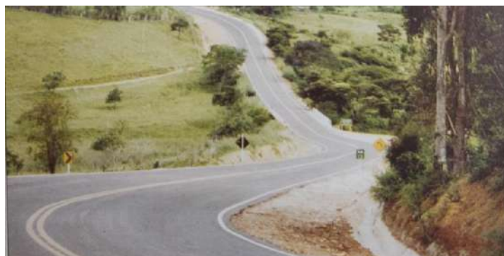
Figura - 19: Pavimentação da BA – 641, trecho Sede – Lucaia, 2004. Fonte: Arquivo Público, Cinquentenário de Barra do Choça - 2012.
