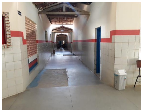
Figura 6 - Segundo Corredor Principal do MCPM de Belo Campo – 2024
