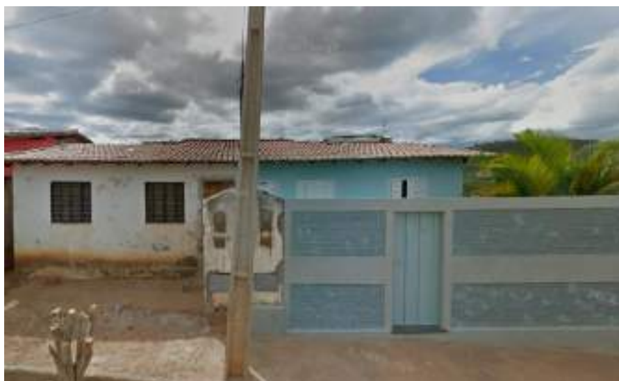
Fotografia 7: Unidade habitacional do conjunto São Sebastião em Brumado-Ba, 2024
