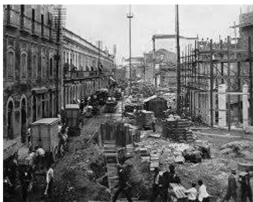
Fotografia 3: Alargamento da Rua Carioca na cidade do Rio de Janeiro-RJ, 1906.
