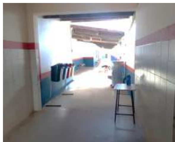
Figura 5 - Corredor menor, que dá acesso ao laboratório PROINFO do MCPM de Belo Campo - 2024
