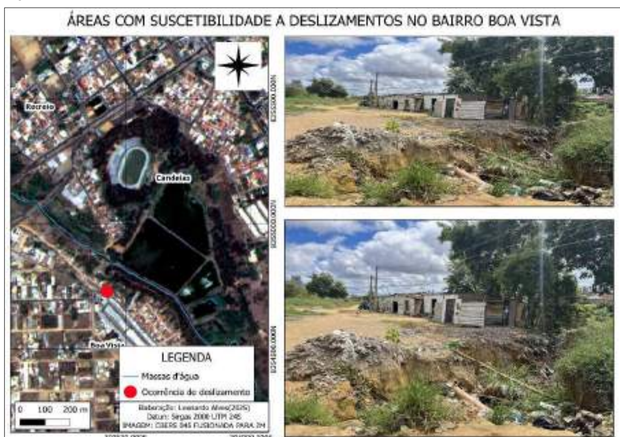
Figura 23 - Áreas com suscetibilidade a deslizamentos no bairro Boa Vista
