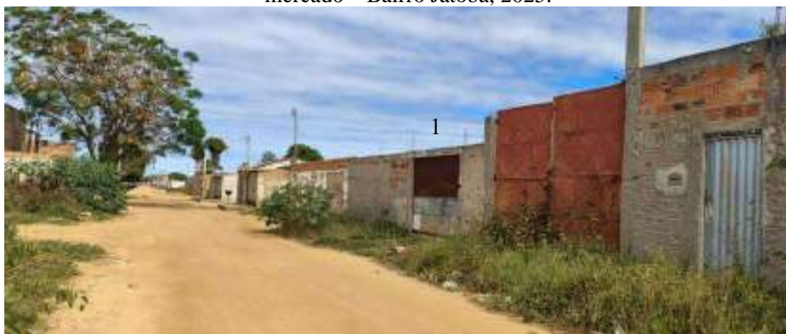
Foto 10 – Condições de moradias no contexto da expansão urbana orientada pelo mercado – Bairro Jatobá, 2025.
