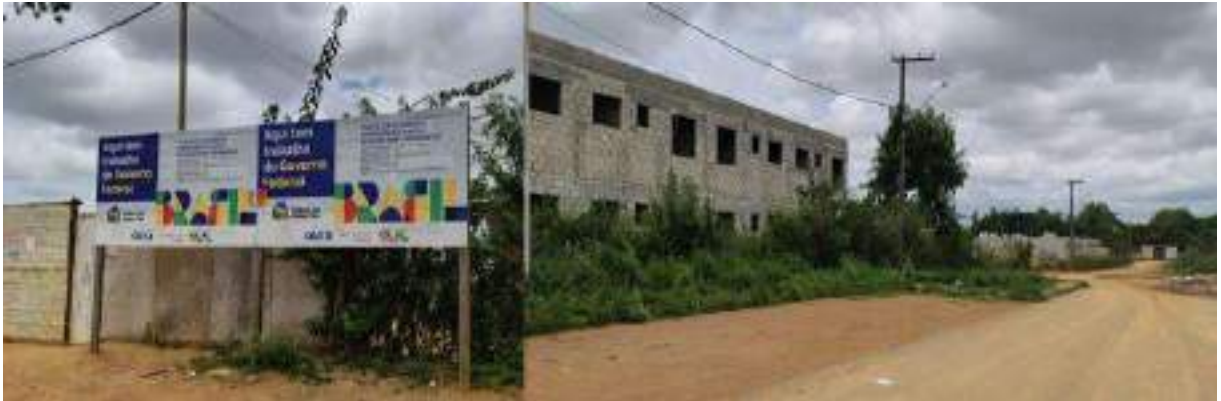
Foto 4 – Empreendimentos do Programa MCMV em execução – Bairro Espírito Santo, 2025.
