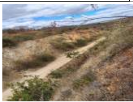
Figura 18- corte de estrada (rocha) FIOI.
