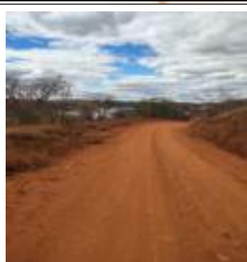
Figura 15- Corte de estrada FIOI.
