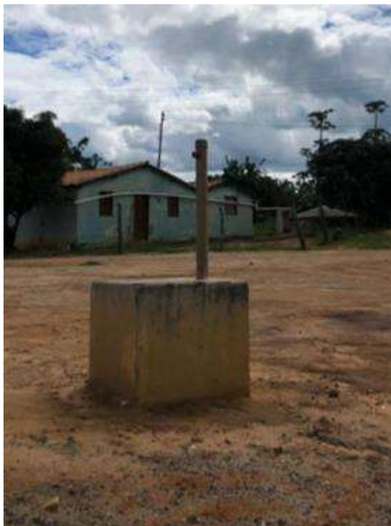
Figura 7 - Chafariz para abastecimento de água (sistema antigo de abastecimento)
