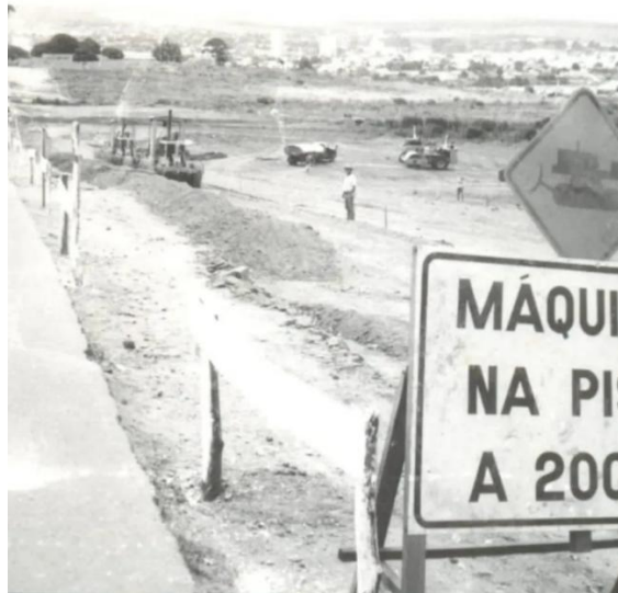
Figura 25 – Obras de limpeza da área da planície de inundação do Rio Verruga.
