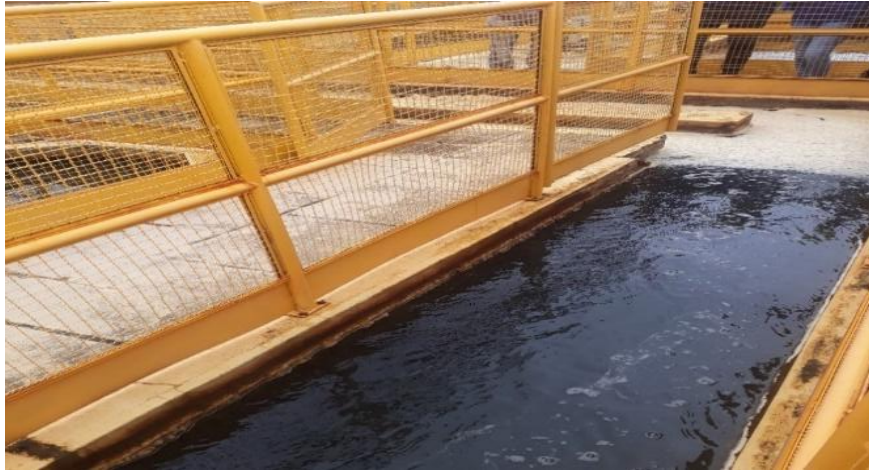
Figura 16 – Etapa 1: Adição de coagulante e alcalinizante na água bruta
