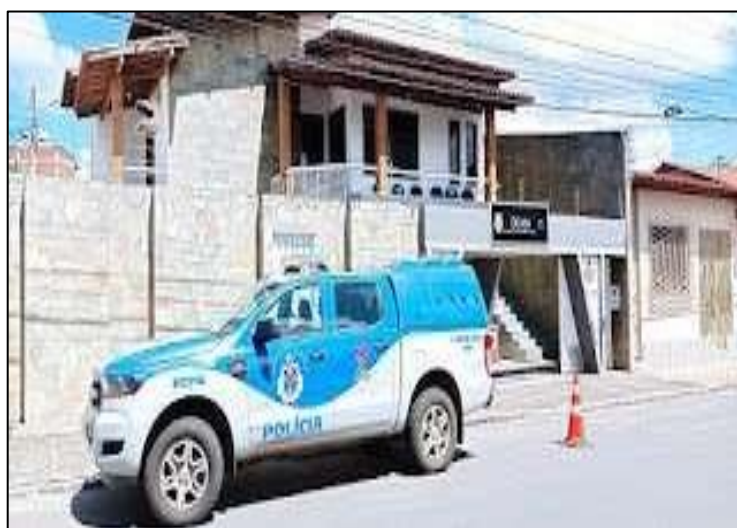
Figura 6 – Prédio em que situava a DEAM de Jequié-BA – Rua Manoel Vitorino (2021)
