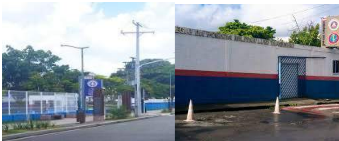
Figura 1: Fachada dos CPMs em Salvador-Bahia.
